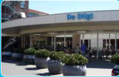
De Dilgt Dilgtweg 3, 9751 ND Haren
